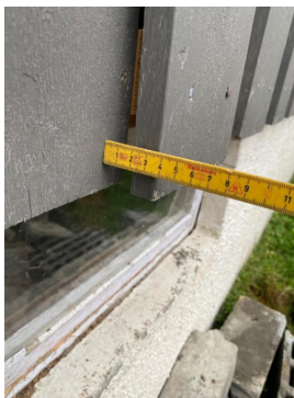
Glippe mellom bord på bordkledningen mot nord.
