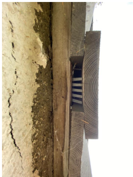
Glippe mellom bord på bordkledningen mot nord.
