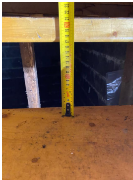
Åpninger mellom trinn ca. 17 cm.
