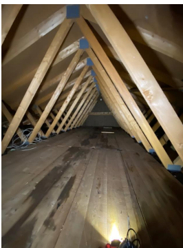
Su-plater har løsnet på enkelte plasser.
