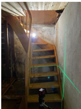
Trapp fra kjeller til hovedetasje.
