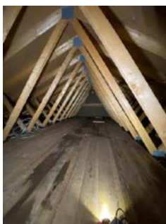
Su-plater har løsnet på enkelte plasser.
