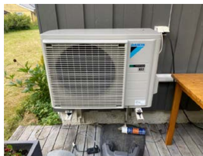
Varmepumpe, utvendig del.
