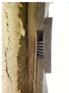
Glippe mellom bord på bordkledningen mot nord.
