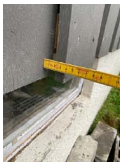
Glippe mellom bord på bordkledningen mot nord.
