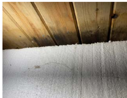
Fukt/svertesopp på panel mot bjelkelaget fra kjelleren.
