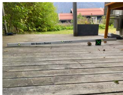
Fall på terrassedekket mot boligen.
