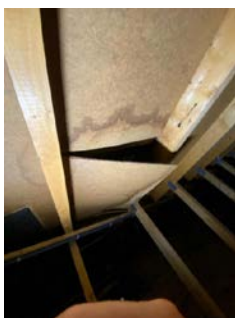
Su-plater har løsnet på enkelte plasser.
