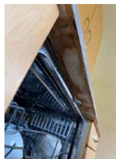
Fuktskade over oppvaskmaskin.
