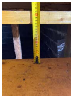
Åpninger mellom trinn ca. 17 cm.
