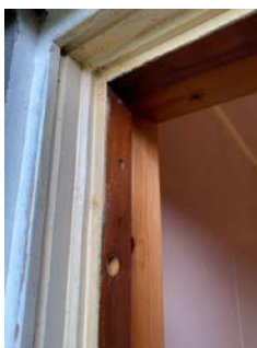
Døren mangler pakning og propper i innfestning.
