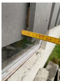
Glippe mellom bord på bordkledningen mot nord.
