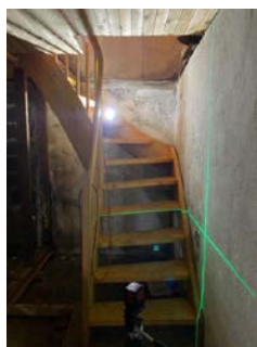
Trapp fra kjeller til hovedetasje.
