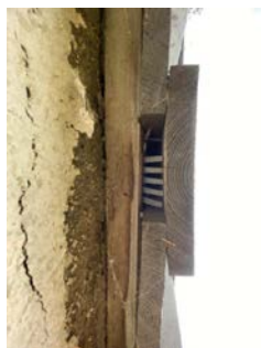
Glippe mellom bord på bordkledningen mot nord.
