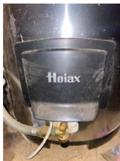
Varmtvannstank av typen Høiax.
