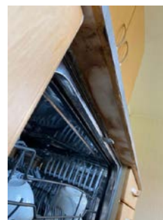
Fuktskade over oppvaskmaskin.
