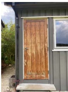
Døren mangler pakning og propper i innfestning.
