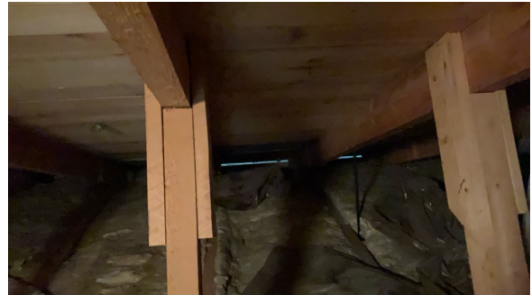
Delvis lufting ut mot yttervegg.
