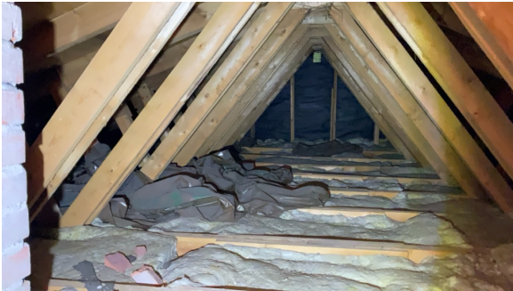
Takkonstruksjon med plassbygde W-takstoler.
