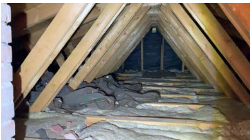
Takkonstruksjon med plassbygde W-takstoler.
