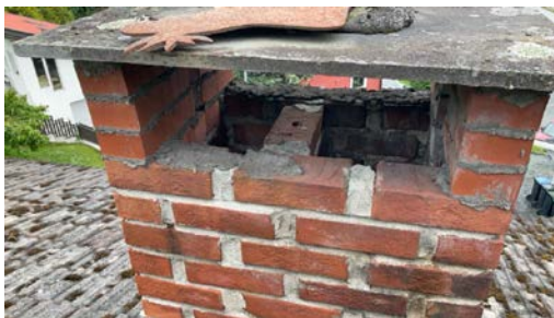
Pipe med luftekanal
