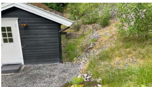
Fall på terreng mot boligen
