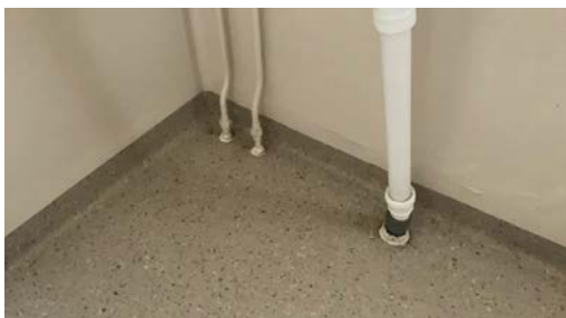
Rørøpplegg kommer opp gjennom gulvet.
