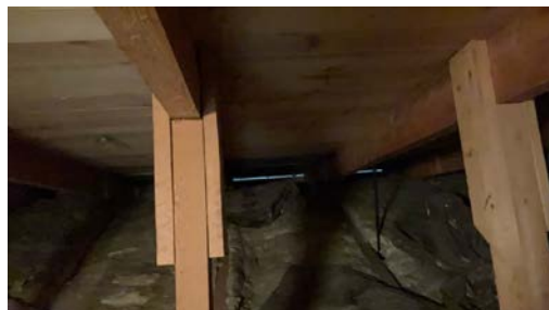
Delvis lufting ut mot yttervegg.
