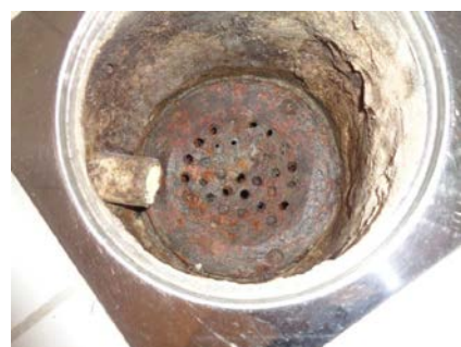
Eldre støpejernsluk på badet.
