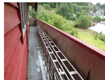
Noe skjevheter i gjerde. Lav høyde på gjerde.
