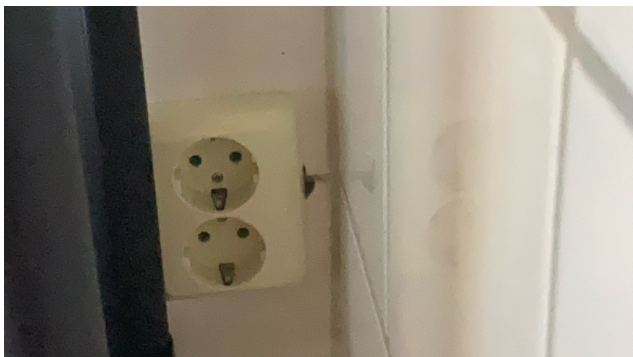
Avskaling på flis ved stikkontakt.
