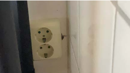
Avskaling på flis ved stikkontakt.
