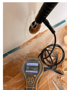
Fuktmåling i vegg mot våtzone
