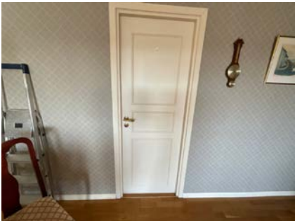
Soveromsdør i stue
