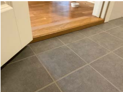
Oppkant mot dørterskel
