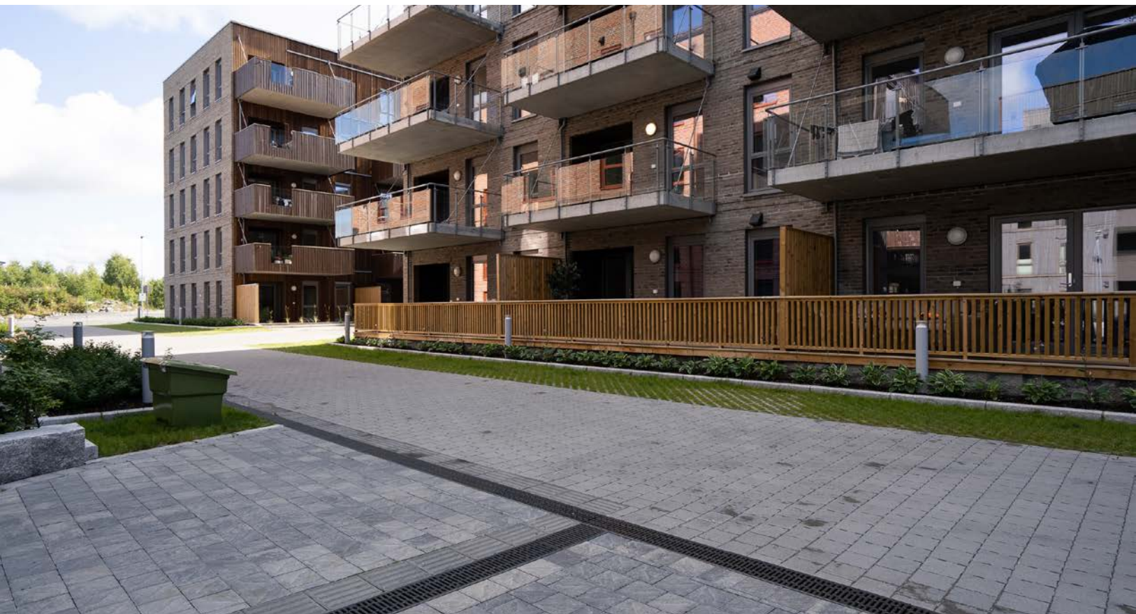
Bilde fra Nabosameiet Skogmo Park trinn 1 som er ferdigstilt.
