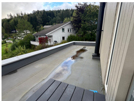
Taktekking over 2. etasje.
