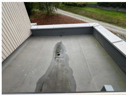
Taktekking over 2. etasje.
