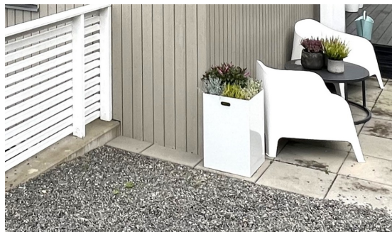
Trekledning ned mot grunnen.
