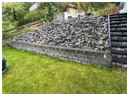
Stablemur på nordsiden.
