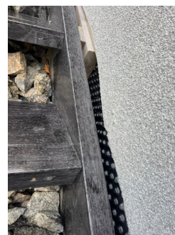
Utvendig tettesjikt utenpå fasadeplater.
