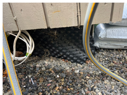
Noe utetthet i tettesjikt på hushjørnet.
