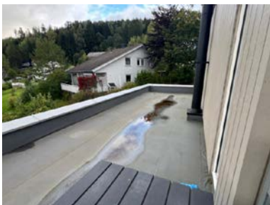
Taktekking over 2. etasje.
