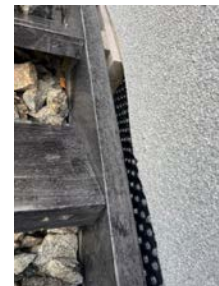
Utvendig tettesjikt utenpå fasadeplater.
