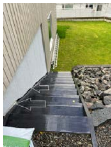
Gavlvegg Nordsid. Utett utvendig tettesjikt.
