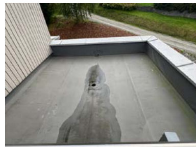
Taktekking over 2. etasje.
