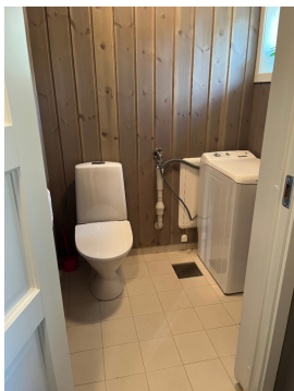
Toalettrom med opplegg for vaskemaskin.
