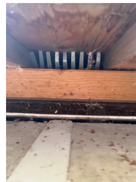
Bilde bak kledning viser lufting og musebånd.
