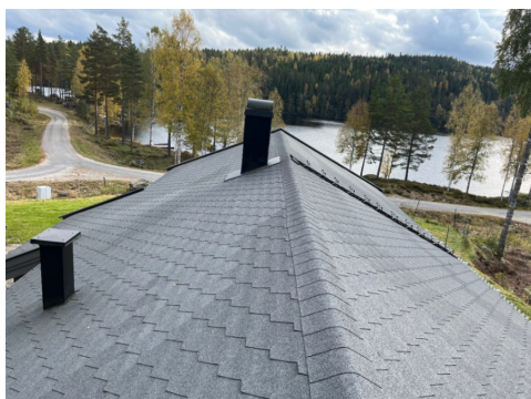
Taktekking med takstige til pipe.
