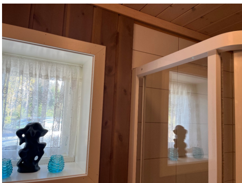
Trepanel og vindu i våtzone til dusj.
