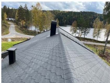
Taktekking med takstige til pipe.
