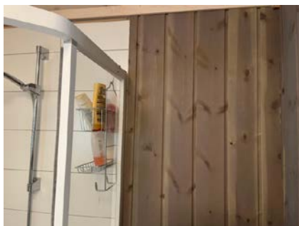
Trepanel på vegger i våtsoner til dusj.
