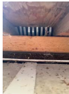
Bilde bak kledning viser lufting og musebånd.
