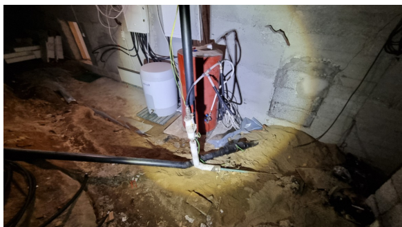
Avløpsrør av plast.
