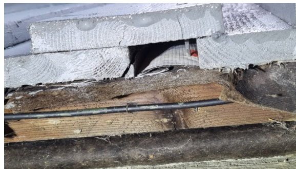
Det er ingen musesperre i nedre kant av konstruksjon, samt at underliggere er montert direkte på vindsperren (ikke lufting bak)
