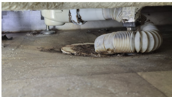
Det er plastsluk og synlig vinylbelegg som tettesjikt.
