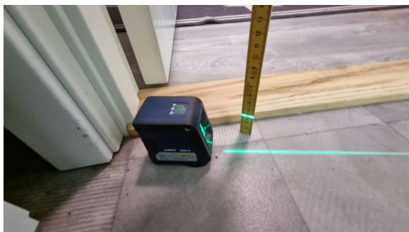
Kontroll av fall og høydeforskjell.
