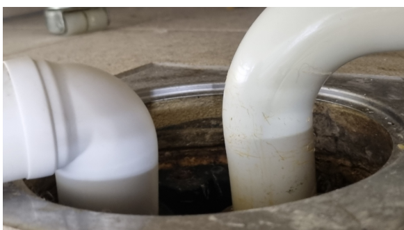
Kontroll av sluk.
