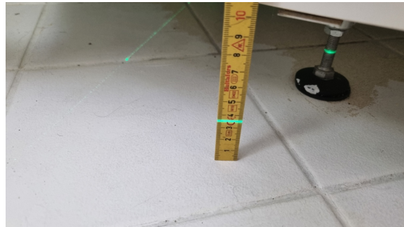
Gulvet har svakt fall mot sluk.
