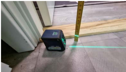
Kontroll av fall og høydeforskjell.
