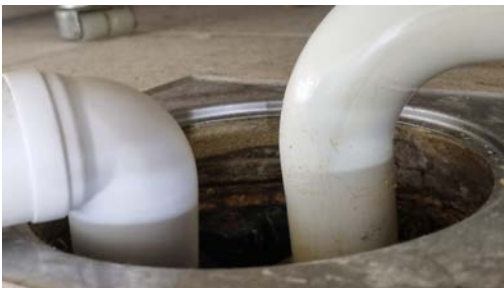
Kontroll av sluk.
