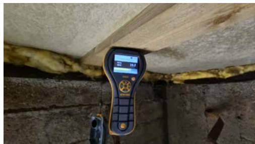
Fuktmåling i stubbegulv.
