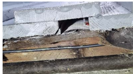
Det er ingen musesperre i nedre kant av konstruksjon, samt at underliggere er montert direkte på vindspærren (ikke lufting bak)
