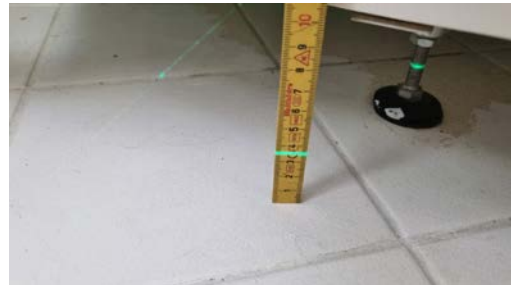
Gulvet har svakt fall mot sluk.
