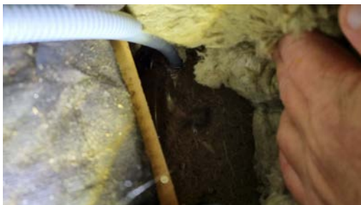
Utettheter rundt gjennomføringer.
