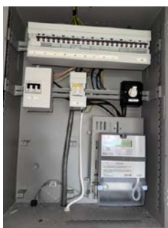
Sikringsskap med automatsikringer.
