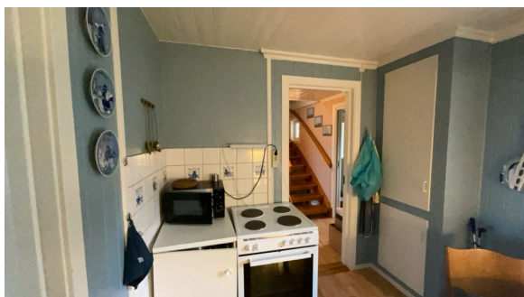
Mangler avtrekk over kokesone.
