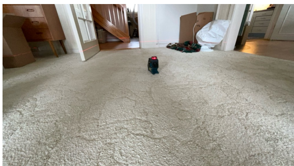
Høydeforskjeller kontrollert.
