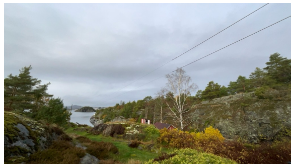
Ledninger fra bolig mot naust.
