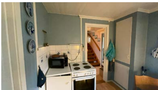
Mangler avtrekk over kokesone.
