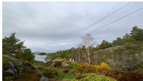
Ledninger fra bolig mot naust.
