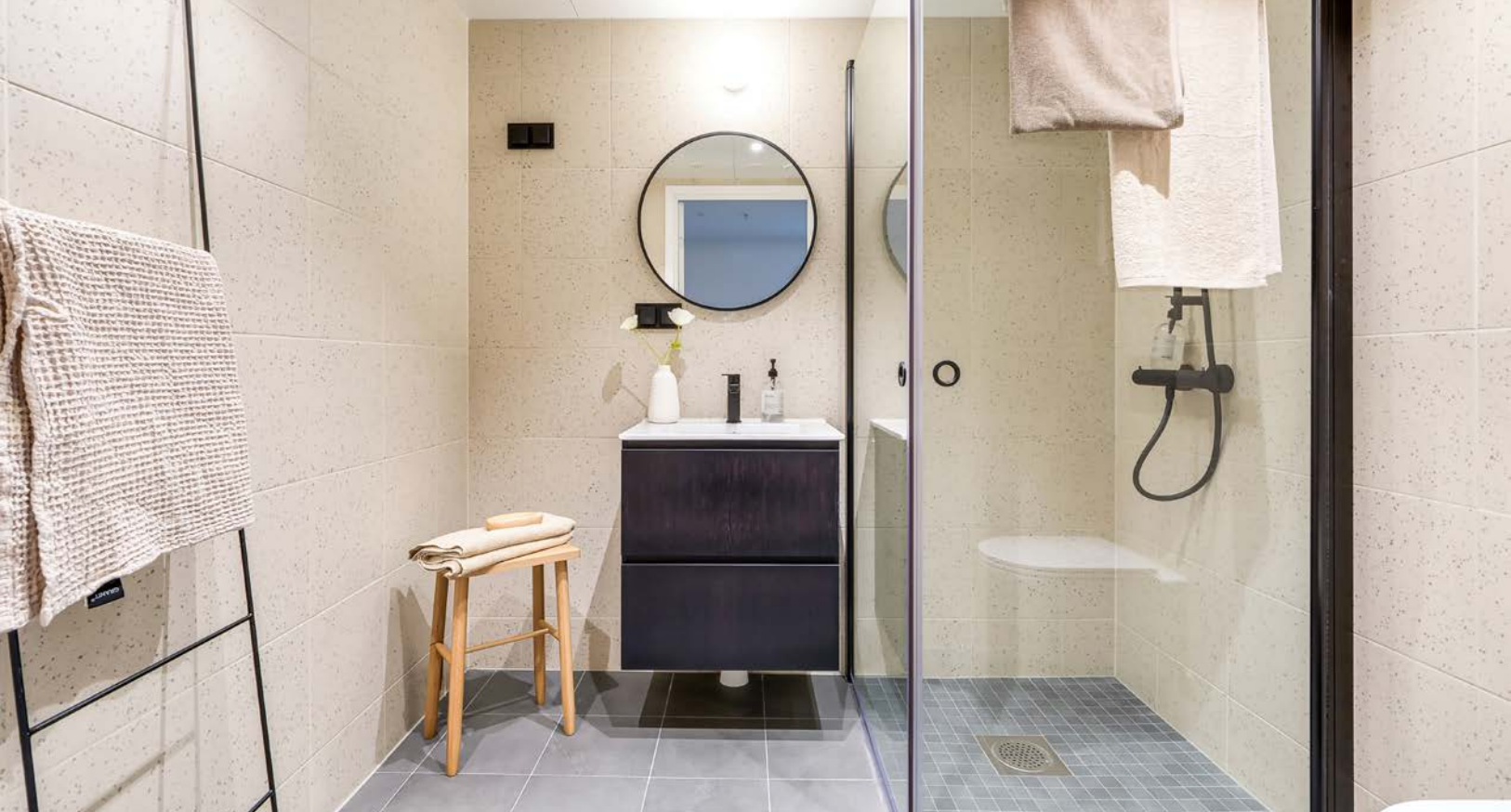
Tidsriktig bad med terrazzofliser på vegg og grå kontrastfliser på gulv. Varmekablene i gulvet holder føttene varme gjennom vinterhalvåret. (Bilder er lånt av tilsvarende leilighet i 3.etasje).
