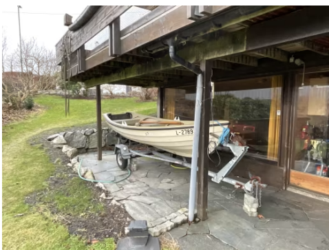
Nedre del av rekkverk har for store åpninger
