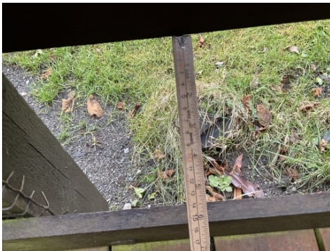
Nedre del av rekkverk har for store åpninger
