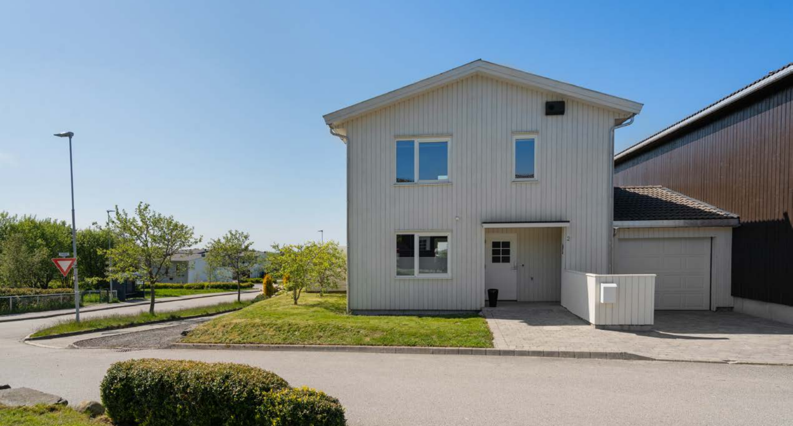
Parkering i garasje samt i gårdsrom. El-bil lader
