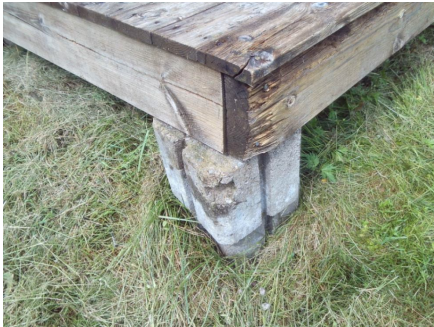
Noe sig i ene pilarer/fundamentering
