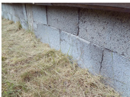
Ringmur av lecablokker i mellom støpte pilarer.
