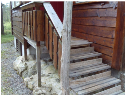
Trapp med repos ved inngangsparti.
