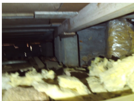
Deler av fundamentering med tilhørende dragere.
