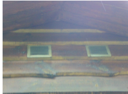
Er satt inn ventiler i begge gavlvegger.
