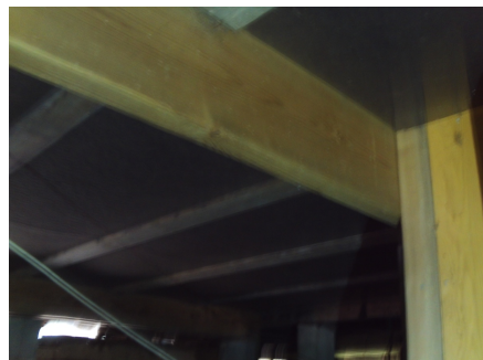
Deler av stubbloftet under tilbygget del.
