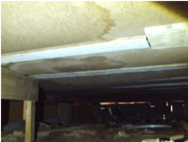
Del av stubbloftet under opprinnelig del.
