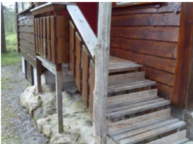
Trapp med repos ved inngangsparti.
