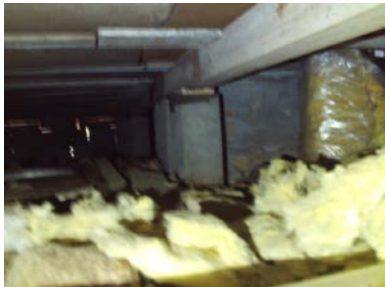
Deler av fundamentering med tilhørende dragere.
