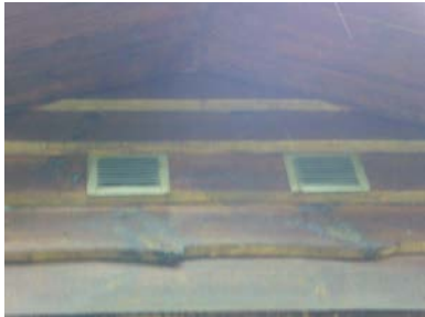
Er satt inn ventiler i begge gavlvegger.
