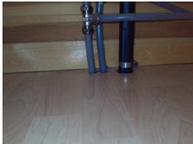
Rørgjennomføringer.
