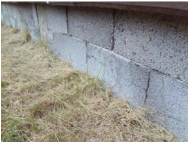
Ringmur av lecablokker i mellom støpte pilarer.
