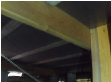
Del av stubbloftet under tilbygget del.
