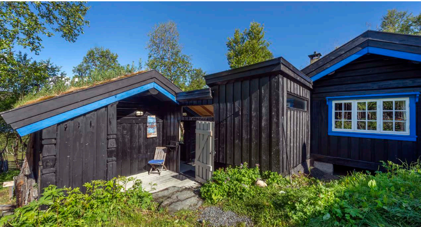
Fra svalgangen er det også gjennomgang til søndre del av eiendommen Her finner en en utvendig bod samt oppgang til eiendommens andre anneks
