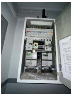
Sikringsskap plassert i felles oppgang.
