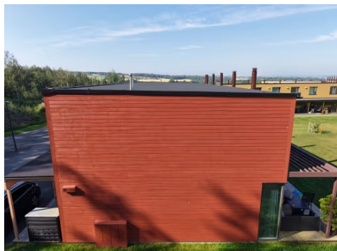
Boligen er oppført med pulttakskonstruksjon.
