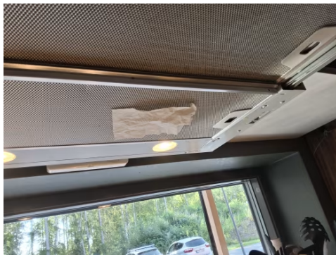
Avtrekkseffekten er testet med papir.
