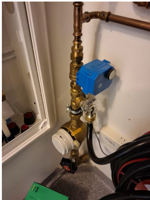
Hovedstoppekrane er plassert i bod under trapp.
