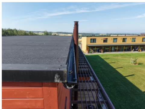
Boligen har takrenner og nedløpsrør i metall.
