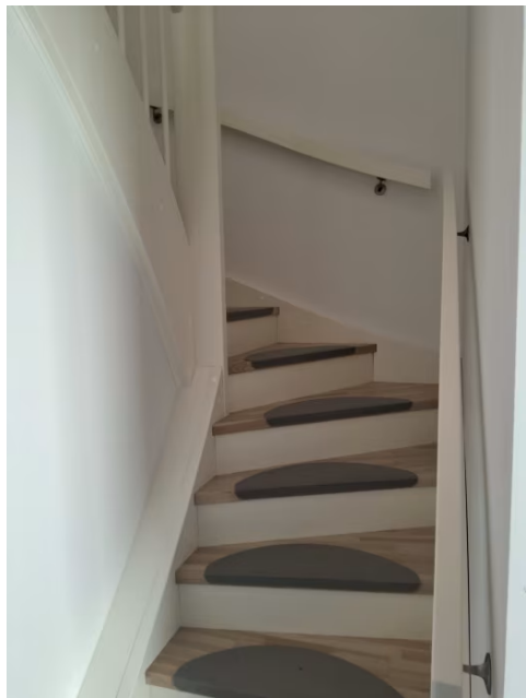
Lukket tretrapp mellom etasjene.
