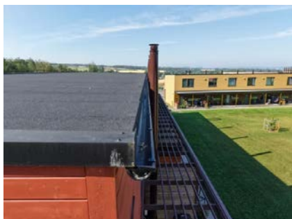
Boligen har takrenner og nedløpsrør i metall.
