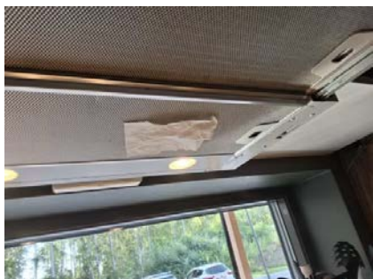
Avtrekkseffekten er testet med papir.
