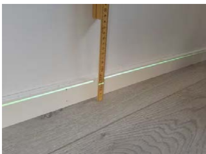
Etasjeskiller er kontrollert med nivelleringslaser.
