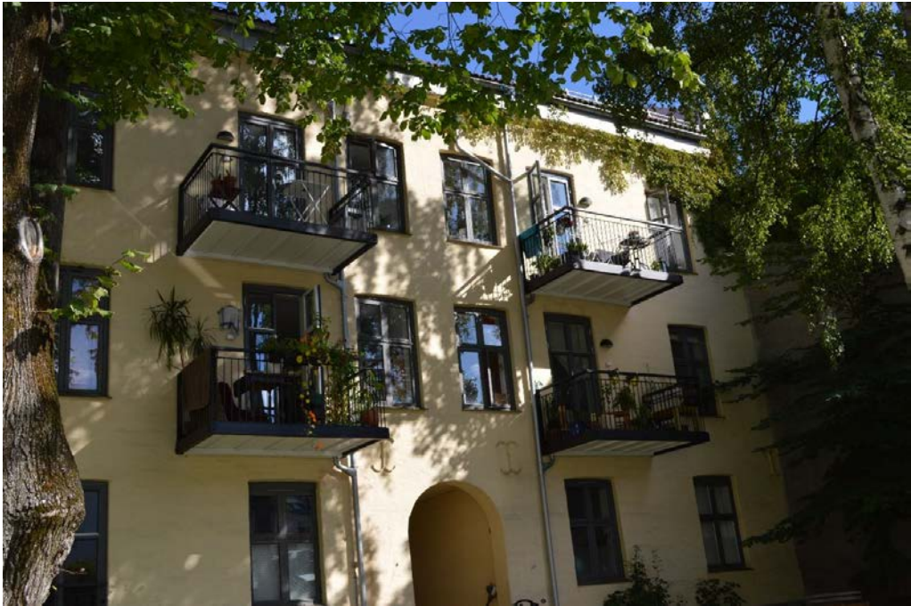
Thorvald Meyers gate 85. Vårt standard rekkeverk type 1900.
