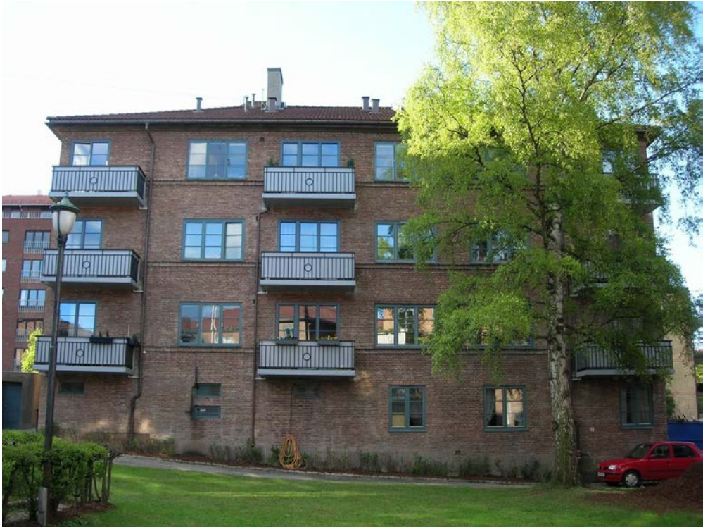
Løvenskioldsgate 22 Oslo. Rekkverk med plater på innsiden.
