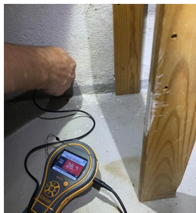
Fuktmåling bod u.etg
