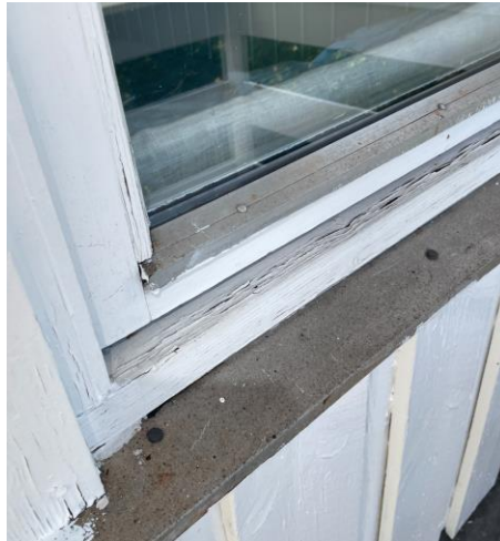
Skade/avflassing vindusomramming
