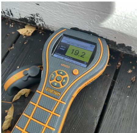
Fuktmåling i kledning
