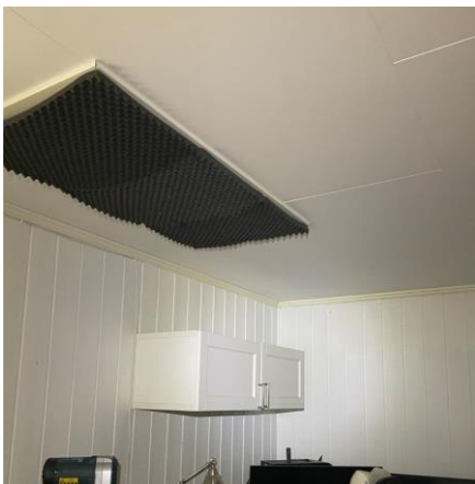
Loftsluke u.etg tilgang til 1. etg
