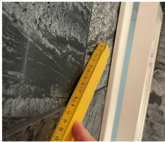
Ujevn flislegging
