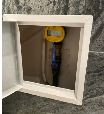
Stoppekran bad u.etg
