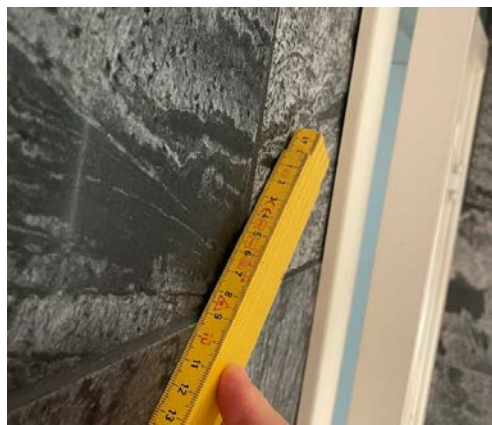
Ujevn flislegging
