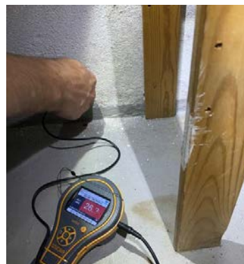
Fuktmåling bod u.etg
