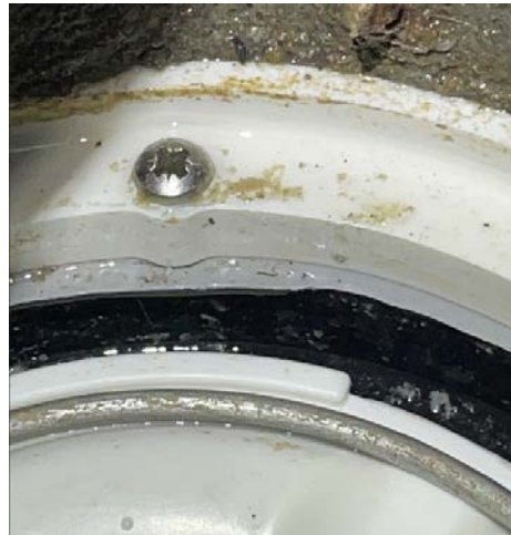
Synlig membran under klemring
