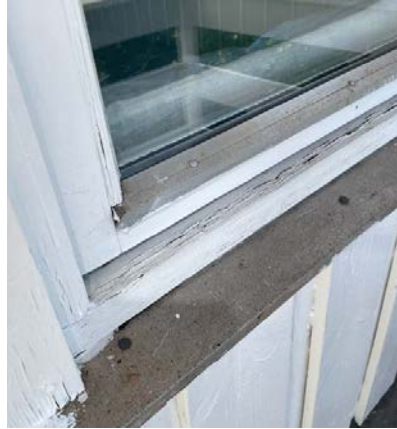
Skade/avflassing vindusomramming
