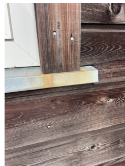
Sideomramning ned mot vannbrett.
