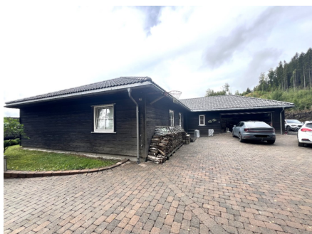
Gårdsplass og gavlvegg mot innkjøring med fall.
