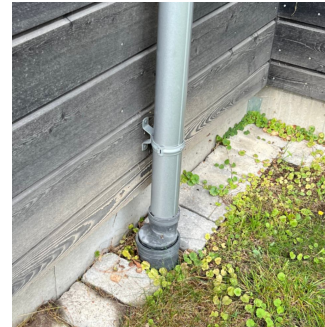
Taknedløp ned i rør/grunnen.
