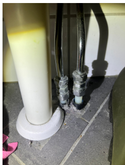
Ingen membransokkel på røroppstikk.
