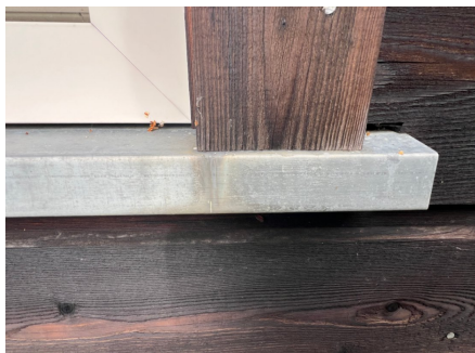
Sideomramning ned mot vannbrett.
