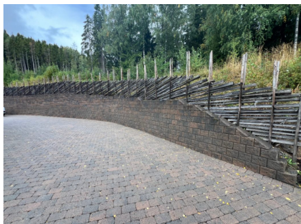
Støttemur med gjerde.
