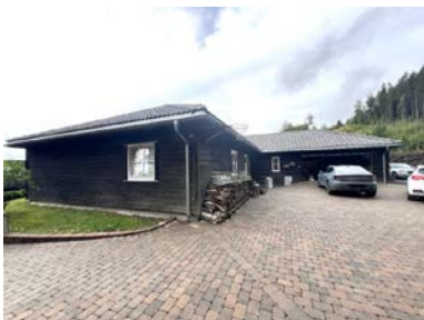
Gårdsplass og gavlvegg mot innkjøring med fall.
