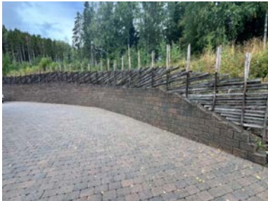
Støttemur med gjerde.
