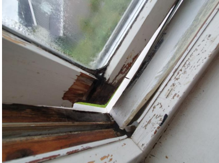
Vindu på soverom sørøst er råteskadet
