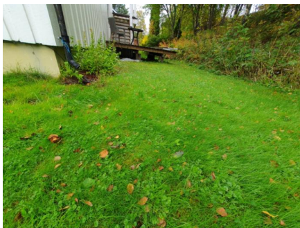
Fall inn mot grunnmur
