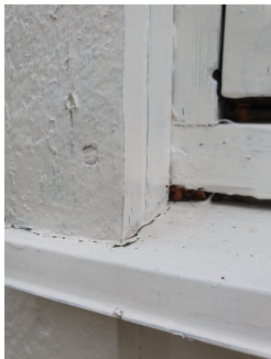
Vindu på soverom sørøst er råteskadet
