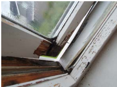
Vindu på soverom sørøst er råteskadet
