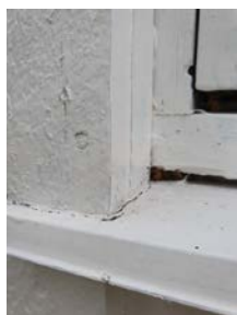
Vindu på soverom sørøst er råteskadet
