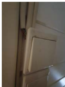
Ikke overdekning av ledning ved bryter
