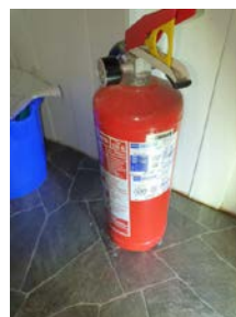
Dato på slokke apparatet viser det er over 10 år
