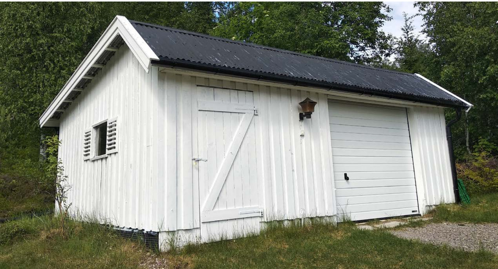
Garasjen har plass for en mindre bil, i tillegg til lagringsplass.
