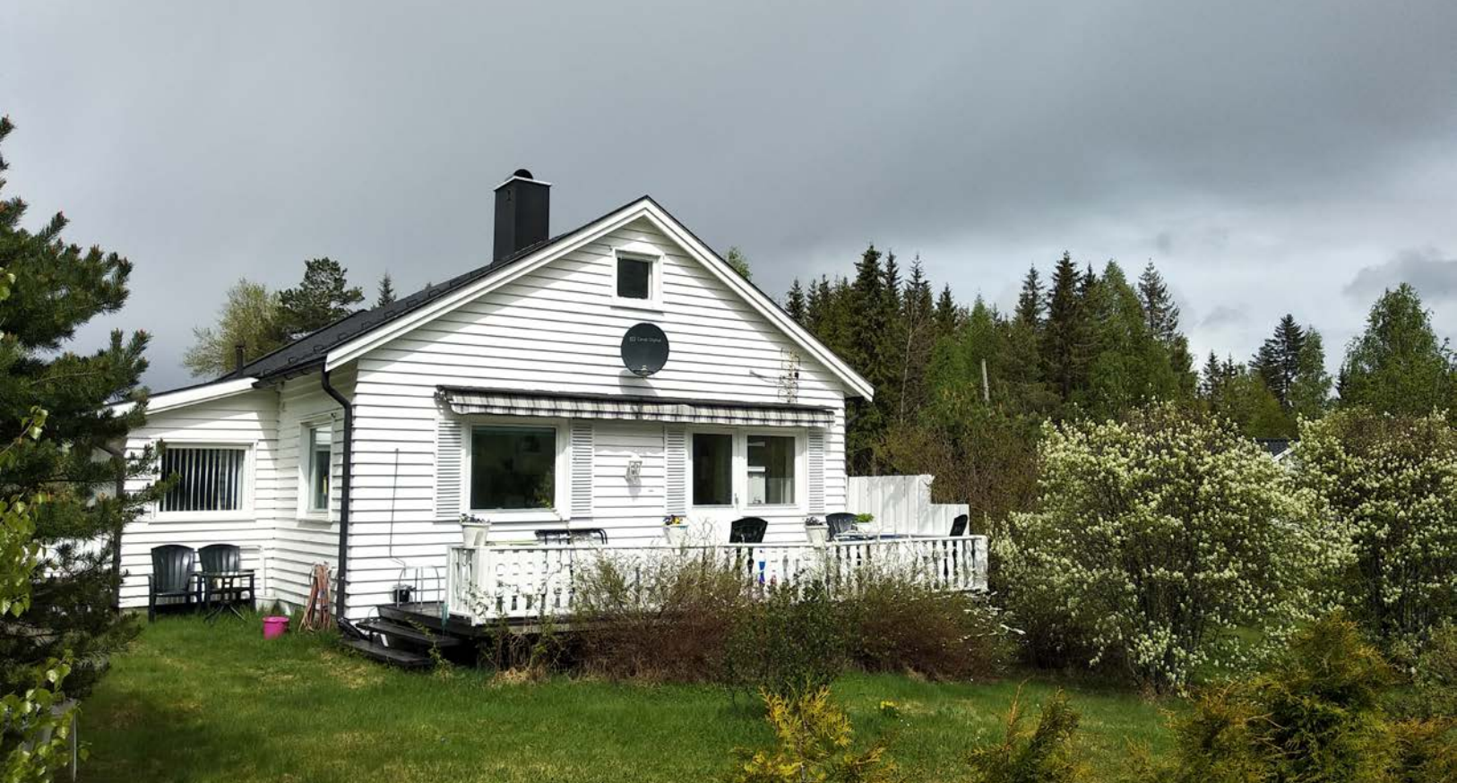
Hage- og fasade sett fra eiendommens sørside.
