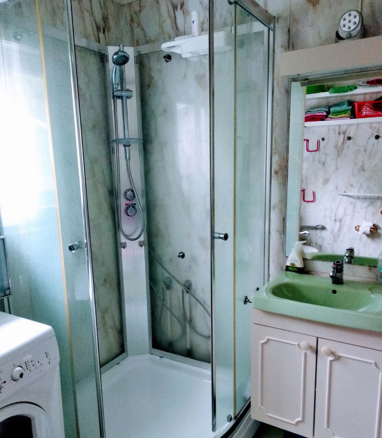
Bad antatt fra 90-tallet, innredet med servant nedfelt i benkeskap, dusjkabinett, frittstående toalett og opplegg for vaskemaskin. Varmekabler i gulv, samt overflater med belegg og våtromsplater.
