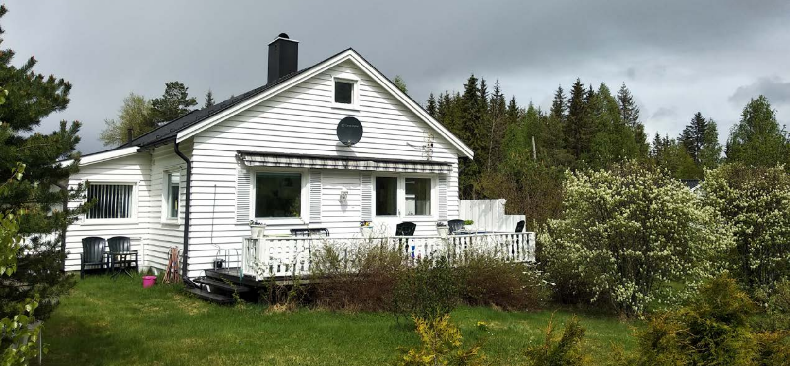
Hage- og fasade sett fra eiendommens sørside.
