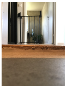
Oppbrett av membran og fugemasse
