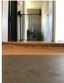
Oppbrett av membran og fugemasse
