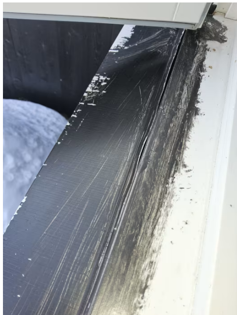
Bilde viser ufagmessig utførelse av vannbrettbeslag.
