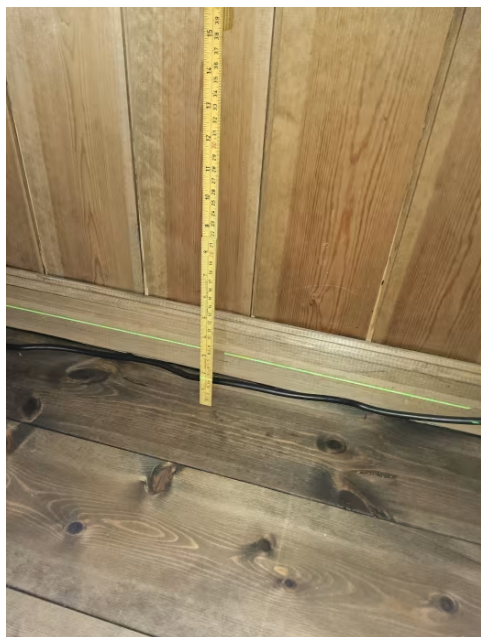
Bilde viser måling av etasjeskiller.
