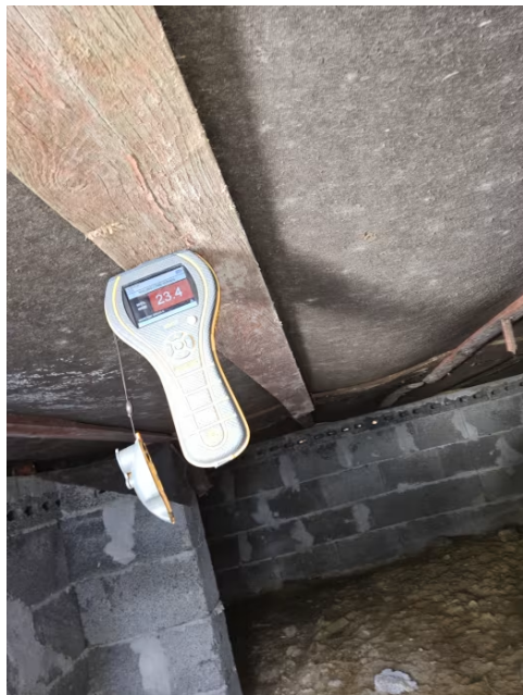
Bilde viser fuktmåling i krypkjeller.
