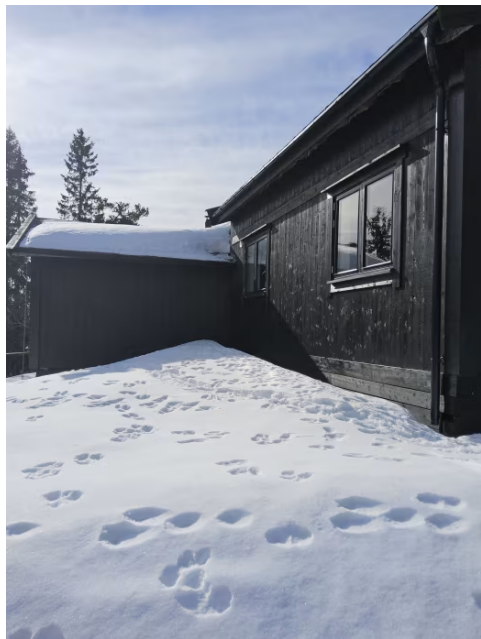
Bilde viser yttervegg.
