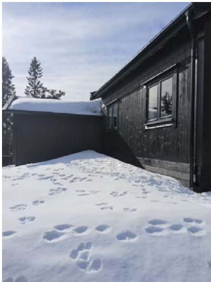
Bilde viser yttervegg.
