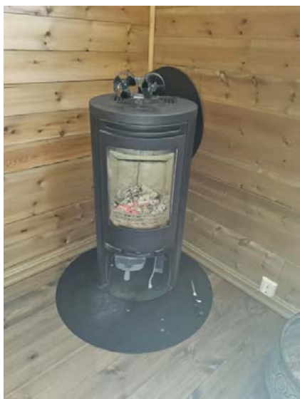
Bilde viser vedovn i stue.
