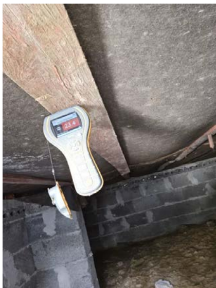
Bilde viser fuktmåling i krypkjeller.
