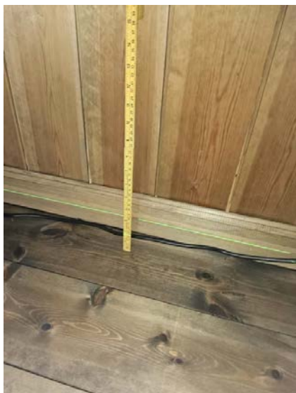
Bilde viser måling av etasjeskiller.
