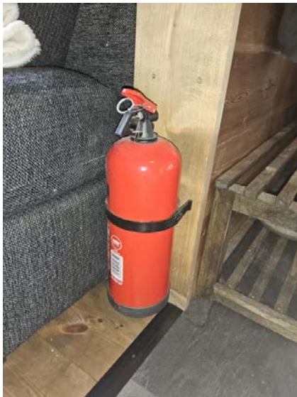
Bilde viser brannslukningsapparat.
