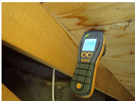
Ingen skadelig fukt målt ved fuktmerker i undertaket.
