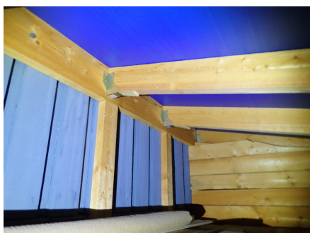
Ingen symptomer på utettheter i overgangen mellom tak og vegg.
