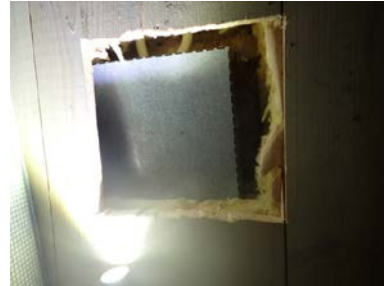
Løse spottkassetter, utettheter dampsperre.
