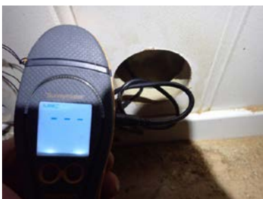
Ingen skadelig fukt i hulltakingen
