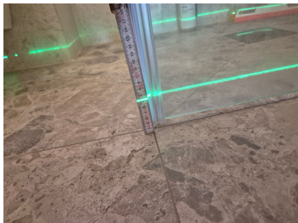
Helt flatt gulv fra ytterhjørne av dusjvegg...
