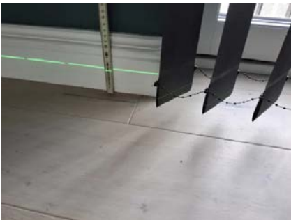
Etasjeskillet er kontrollert med nivelleringslaser.
