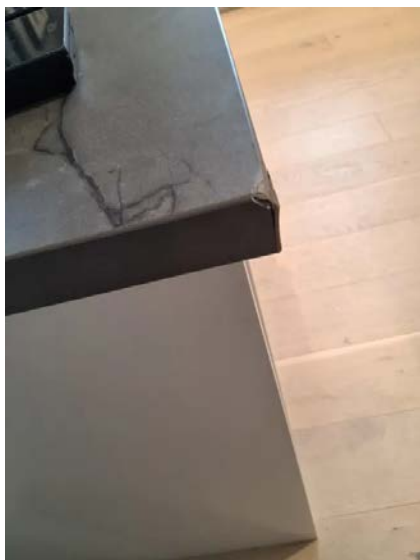
Det registreres en avskalling på ett hjørne på benkeplate.
