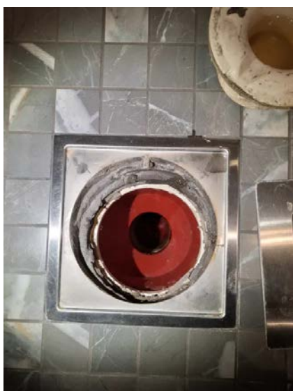
Overgang mellom sluk og membran er dekket
