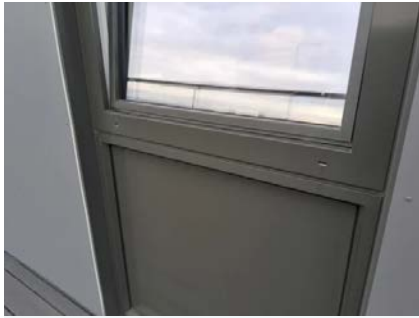
Leiligheten har vinduer med tre-lags glass.
