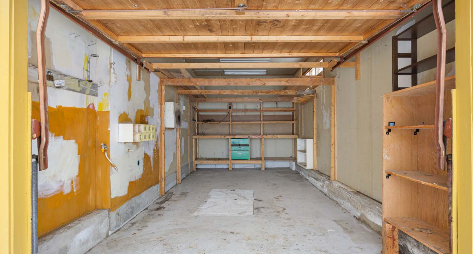
Garasjen er på ca. 20 kvm og har gipsplater på vegger og tak. Gulvet har betongdekke med smøregrav.
