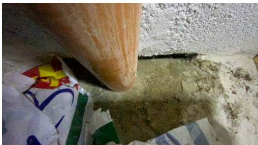
Liten åpning ved mur og kun sand rundt rør.
